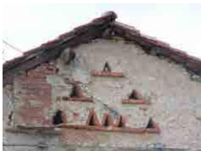
e delle malte, caduta di porzioni di intonaco, macchie, depositi superficiali coerenti, efflorescenze saline.
