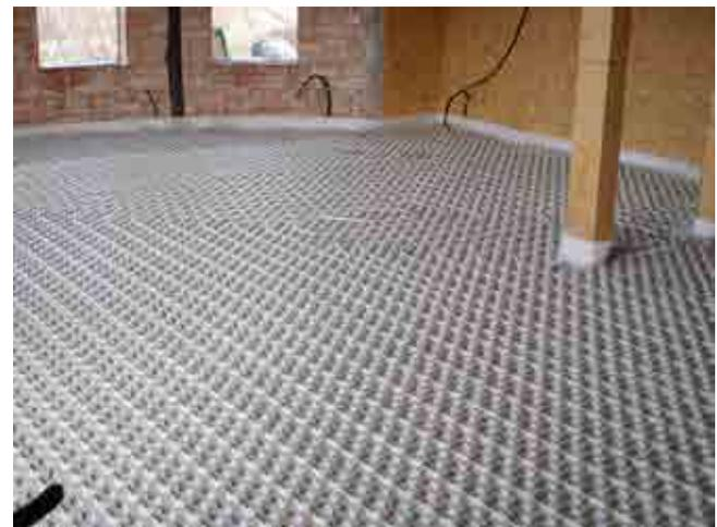
ite in modo uniforme, a serpentina, posizionate all'interno del massetto della pavimentazione, all'interno delle quali circola un fluido a bassa temperatura che riscalda in maniera uniforme l'ambiente.
