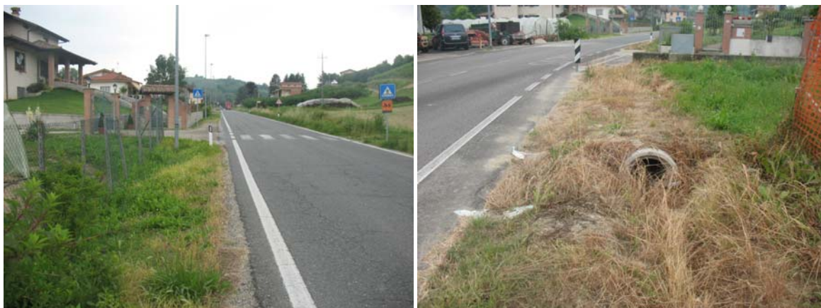
FOTO DI TRATTI DOVE E' PREVISTALA REALIZZAZIONE DI MARCIAPIEDI PEDONALI
